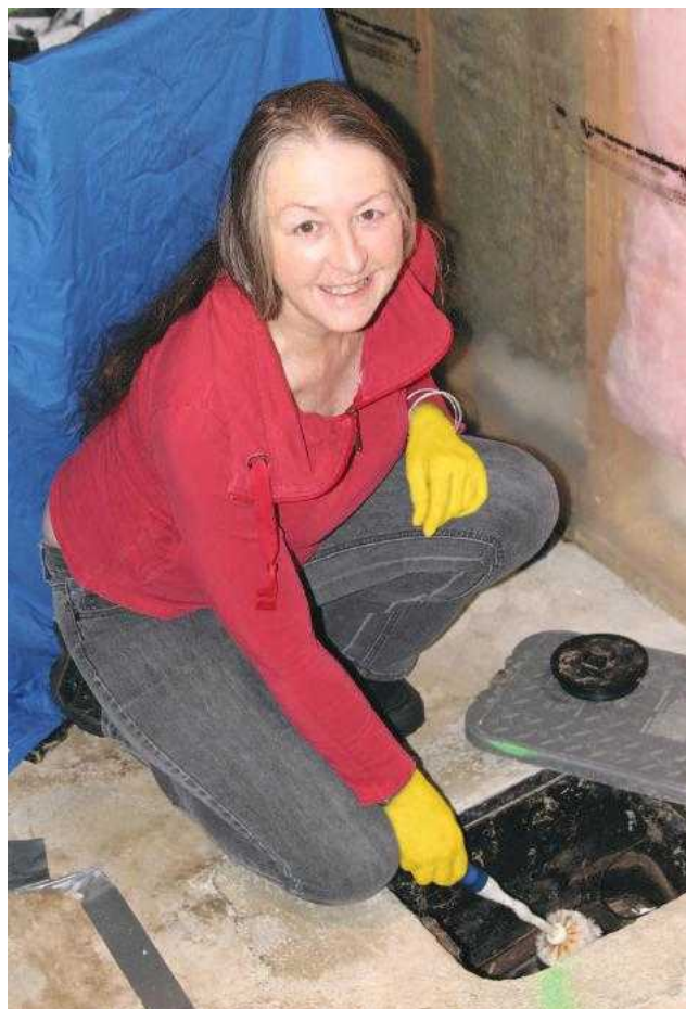
Margaret Banks, propriétaire, fait la démonstration des méthodes de nettoyage de son clapet antiretour une fois par saison pour réduire au maximum les risques de refoulement d'égout. Burlington, 2017
