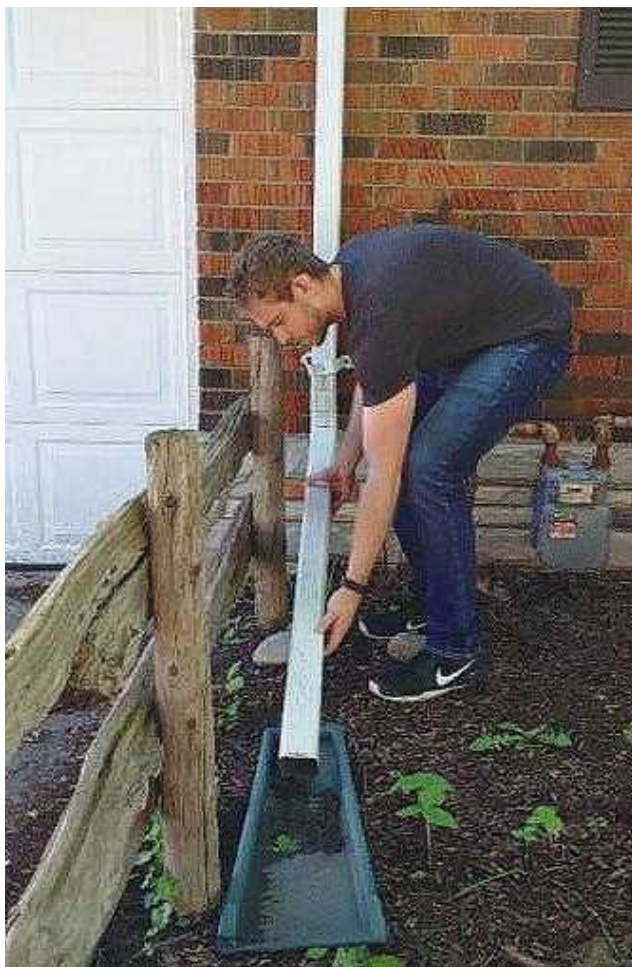
Riley Davidson-Evans, résidant de Waterloo, allonge ses descentes pluviales à 2 m après son évaluation. Waterloo, 2017.
