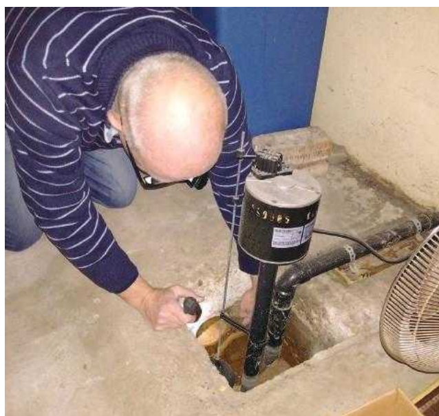
Ron Bolender, formateur en évaluation des risques d'inondation, montre aux élèves comment inspecter un puisard et une pompe. Kitchener, 2017.
